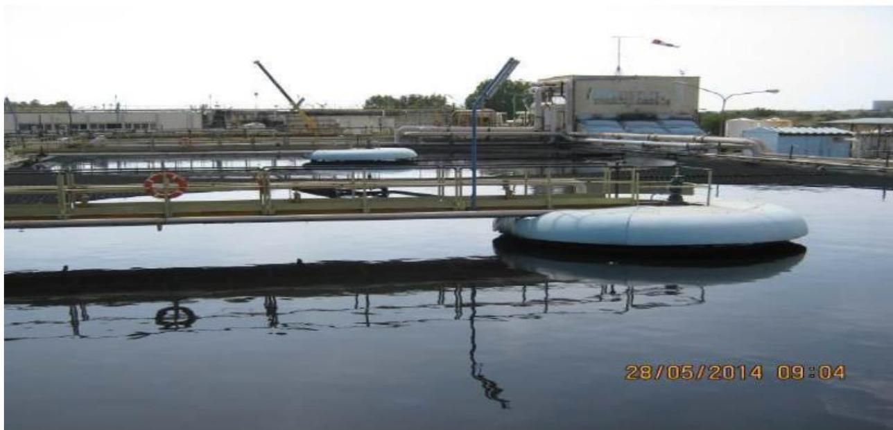
Le 4 vasche sono in cemento armato, non interrate, a pianta circolare, con meccanismo raschifango a due bracci posto al centro di ogni vasca. Il fondo della vasca è leggermente inclinato verso il centro tale da favorire il convogliamento del fango mediante le lame raschifango.
